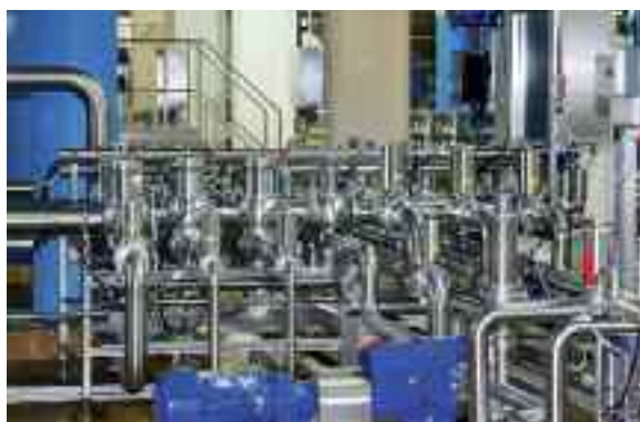
Maintenance préventive en IAA
